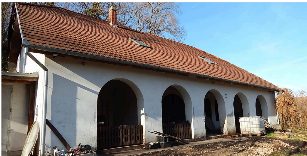
Új épületen hagyományőrző tornác
