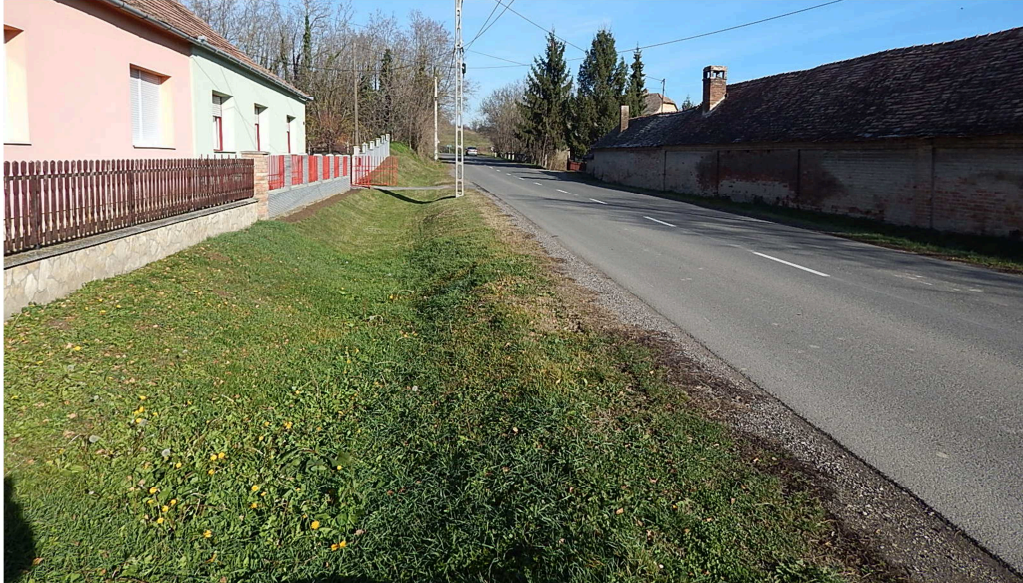
Gondozott vízvezető árok
