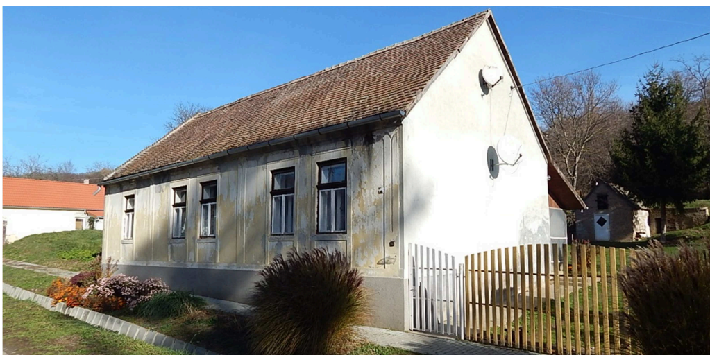
Megtartott tömeg és homlokzat, jó arányú kapuk
