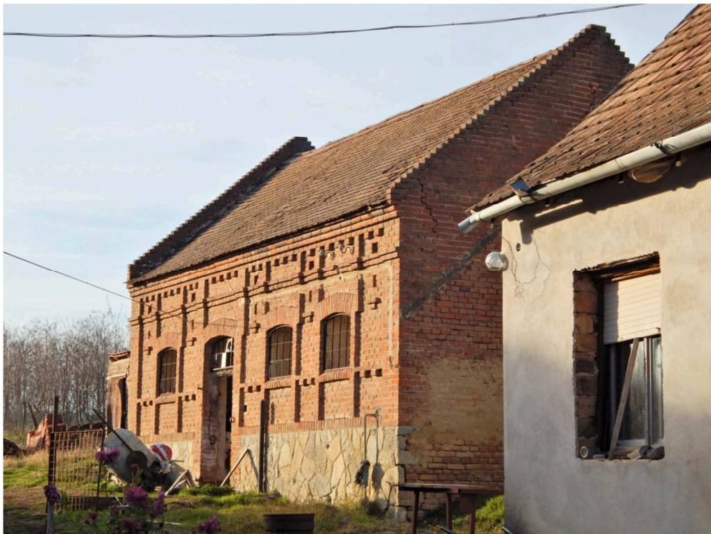
A Fő u. 34. melléképület
