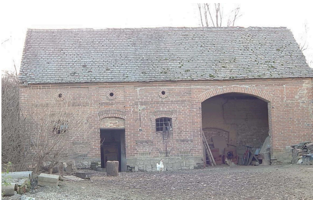
A Fő u. 40. melléképület
